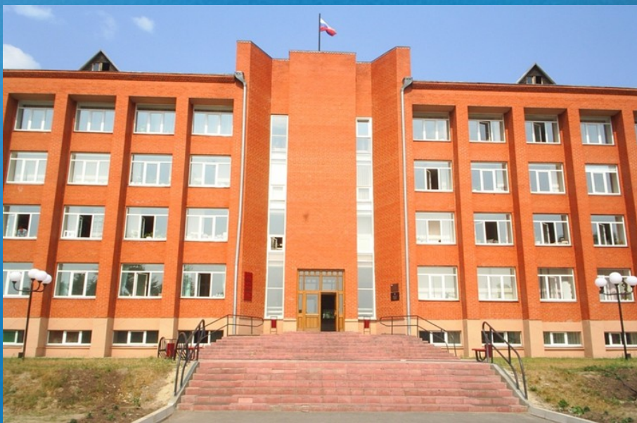
Здание Управления по делам ГО и ЧС Администрации Колпашевского муниципального района
